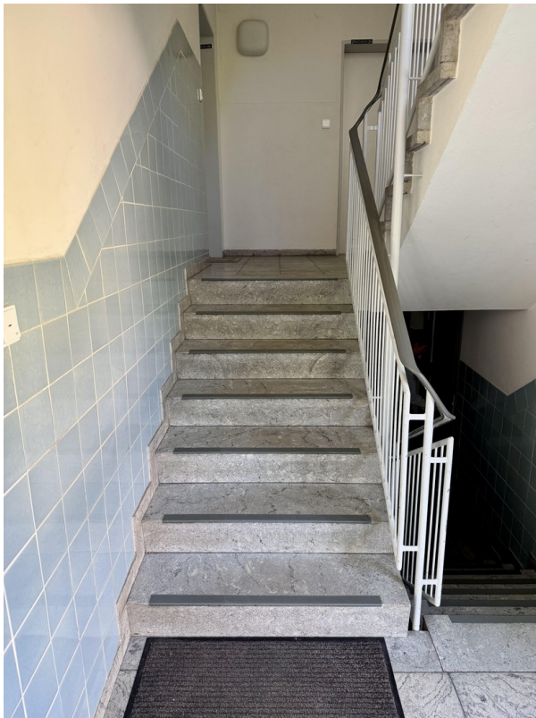
Treppe zur Wohnung
