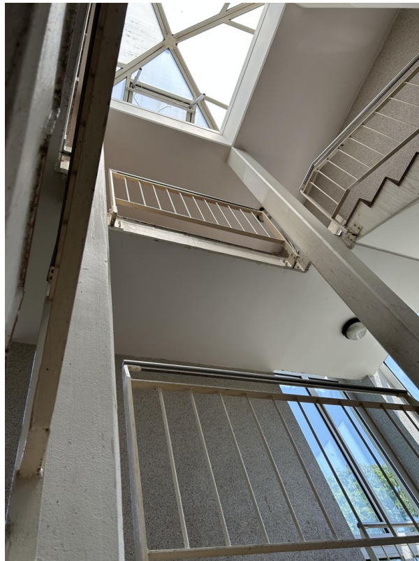
Blick nach oben im Treppenhaus
