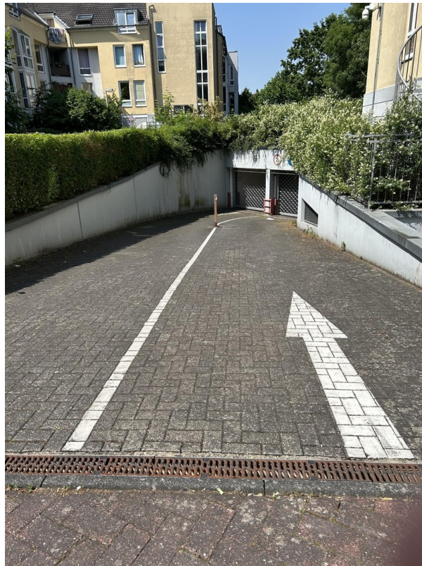
Eifahrt zur Tiefgarage
