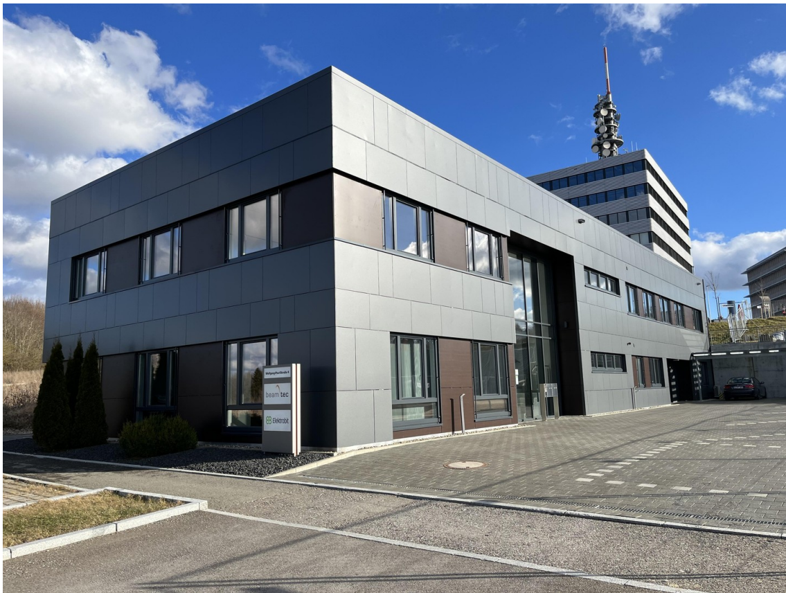
Ansicht Zufahrt, Haupteingang
