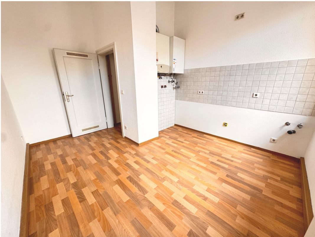
Küche - Einbau neue EBK
