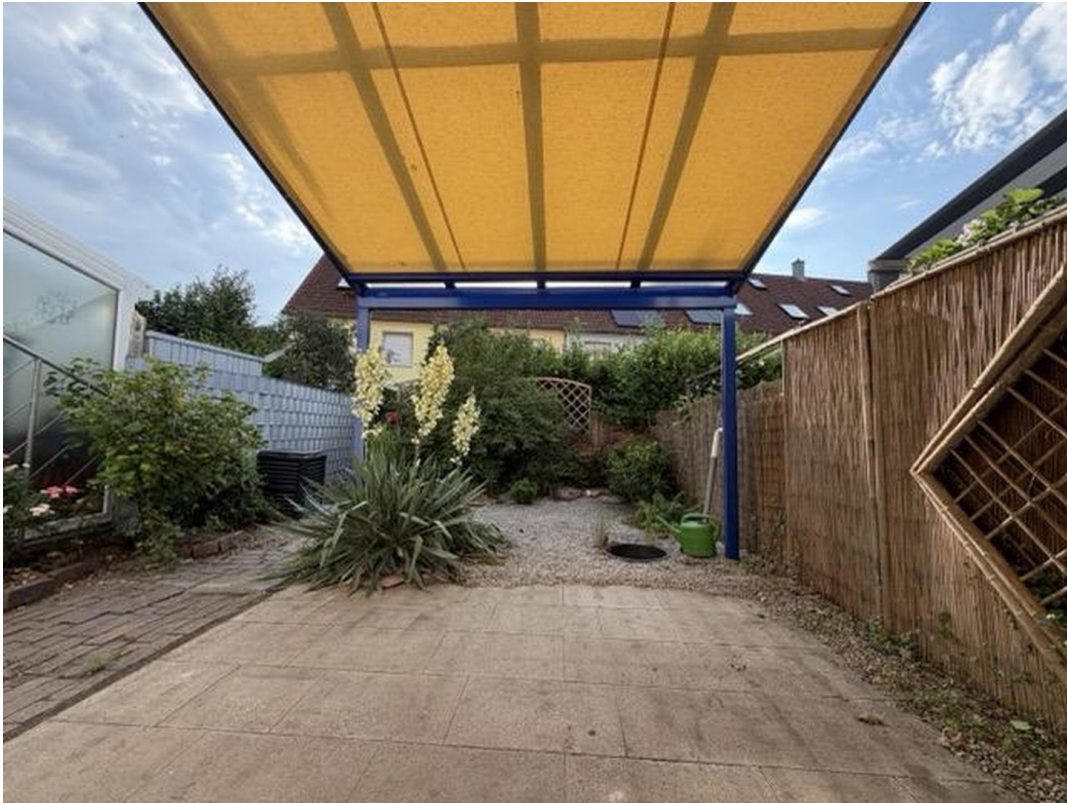
3e_Terrasse Glasdach & Markise
