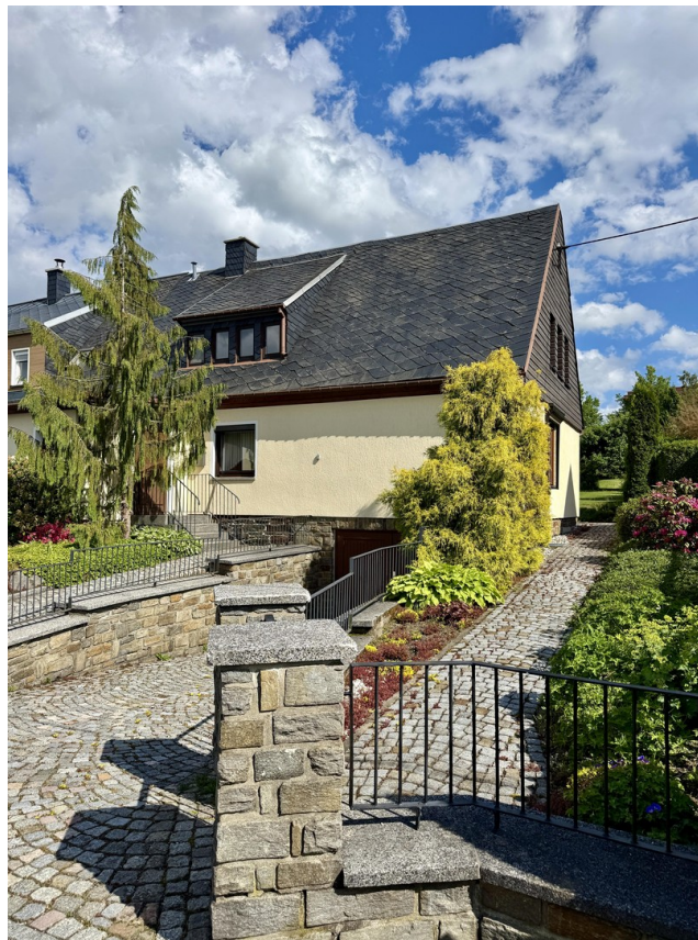
Hausansicht von der Straße
