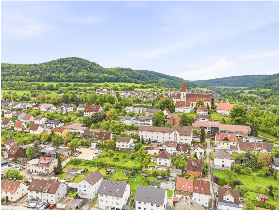
Blick über die Dächer
