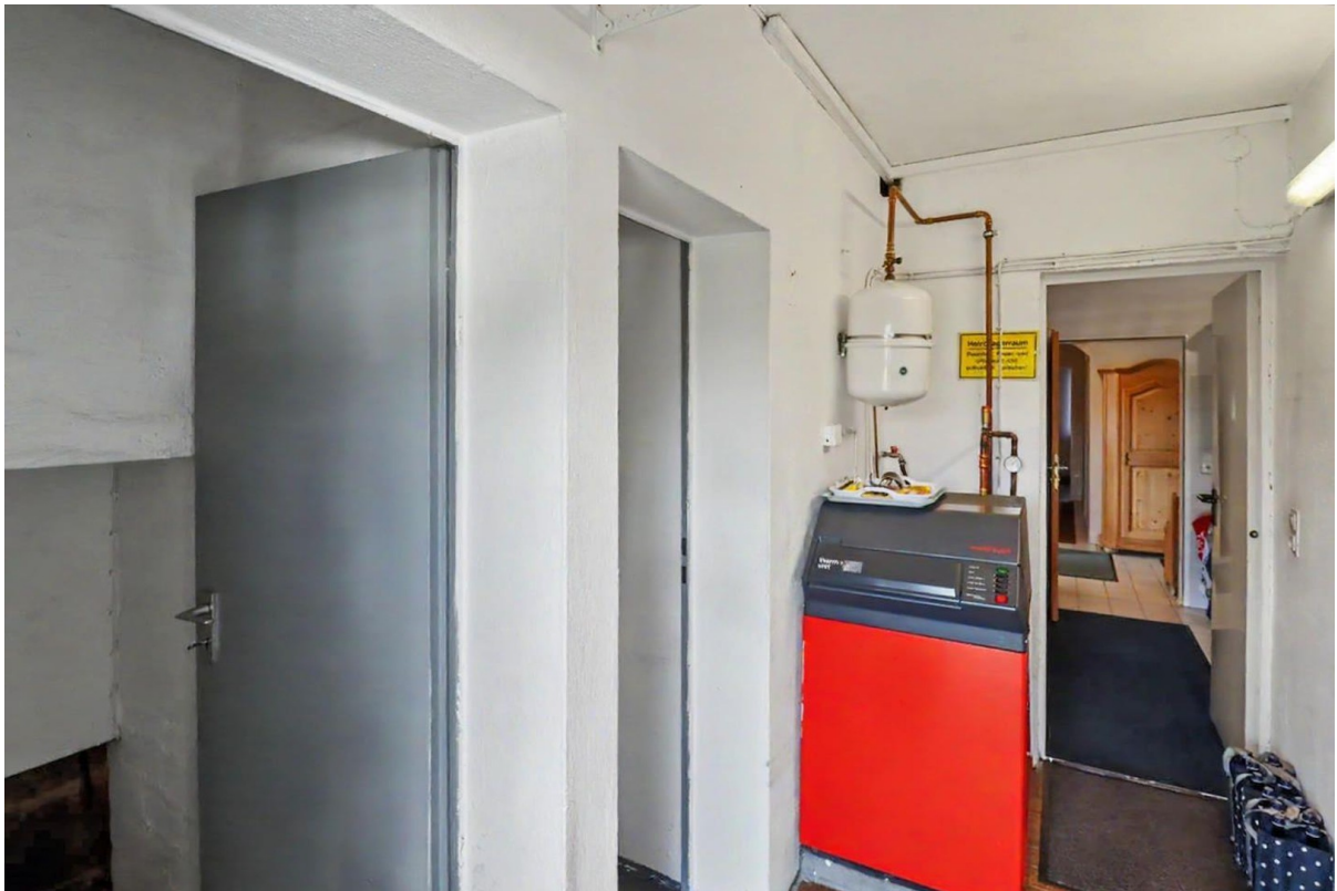
Zugang zum Wirtschaftsraum
