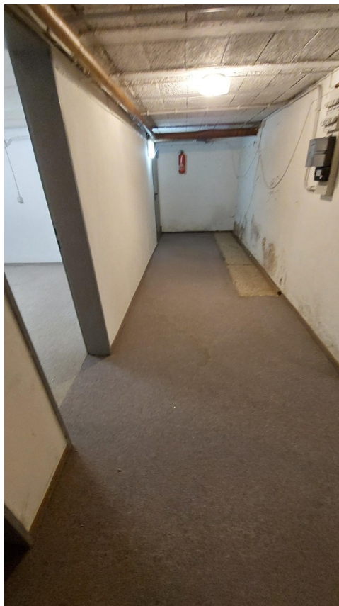
Flur im Keller
