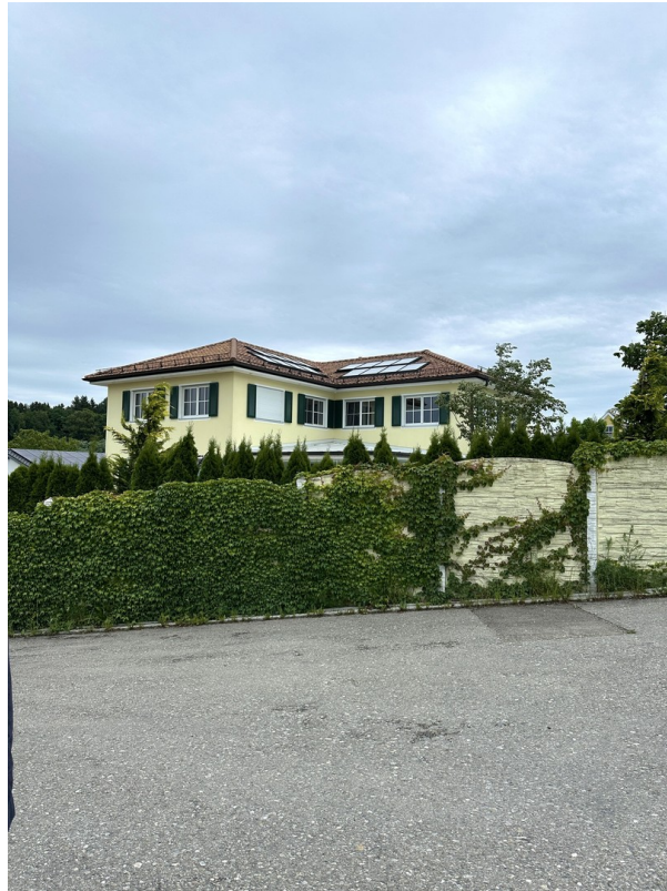
Haus von der Straße
