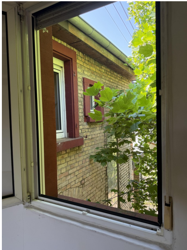
1. OG Blick in den Innenhof
