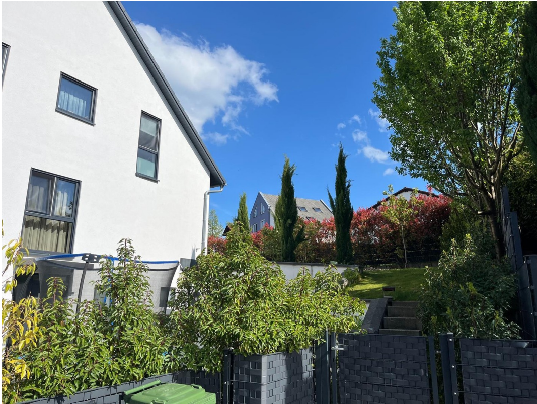
Haus von außen
