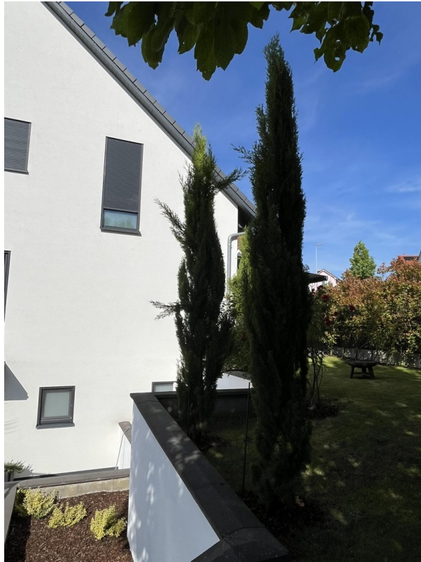
Haus von außen
