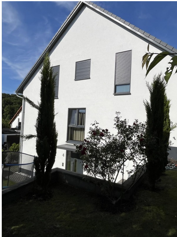
Haus von außen
