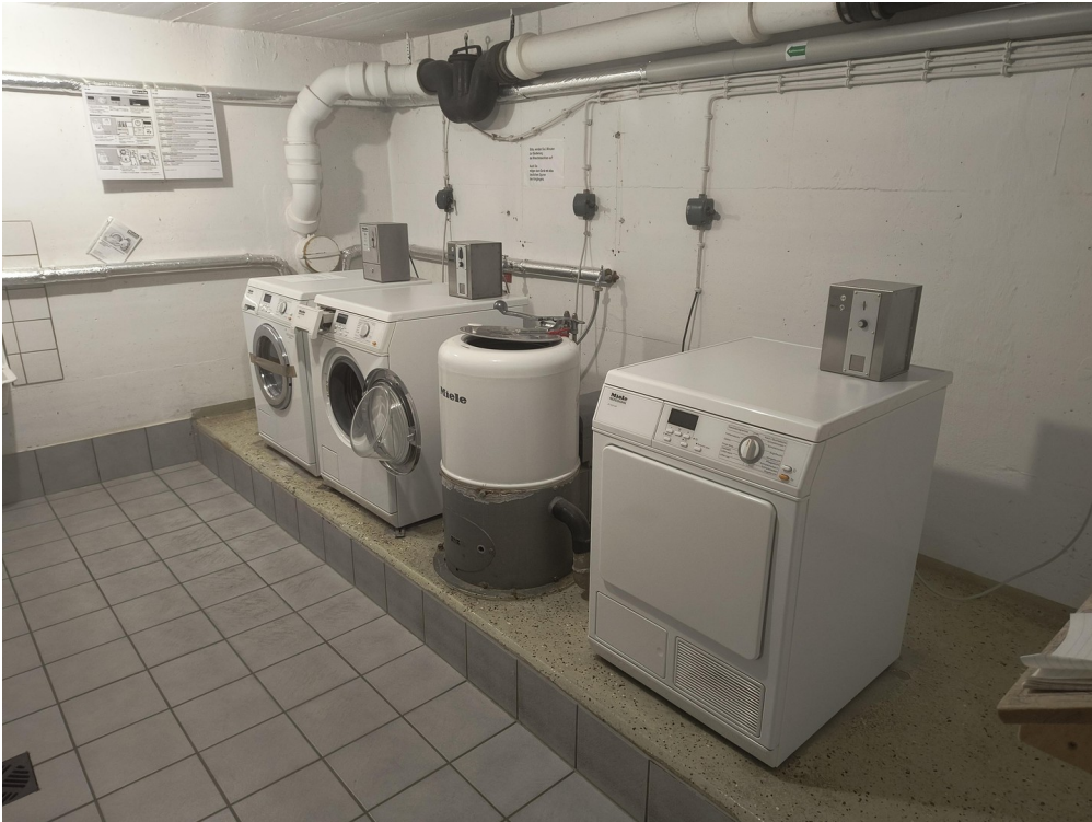
Waschraum im Keller
