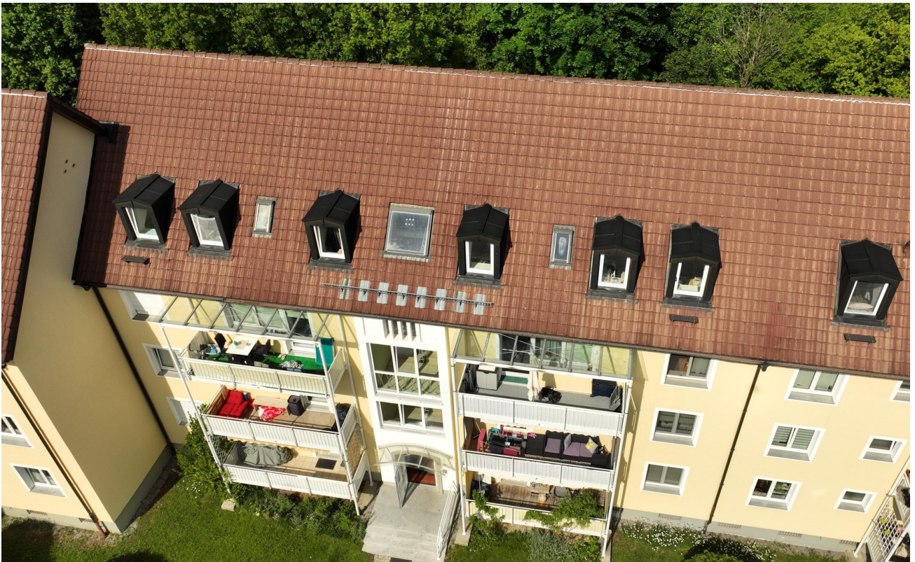
Blick Wohnhaus - 3-Zi.-DG
