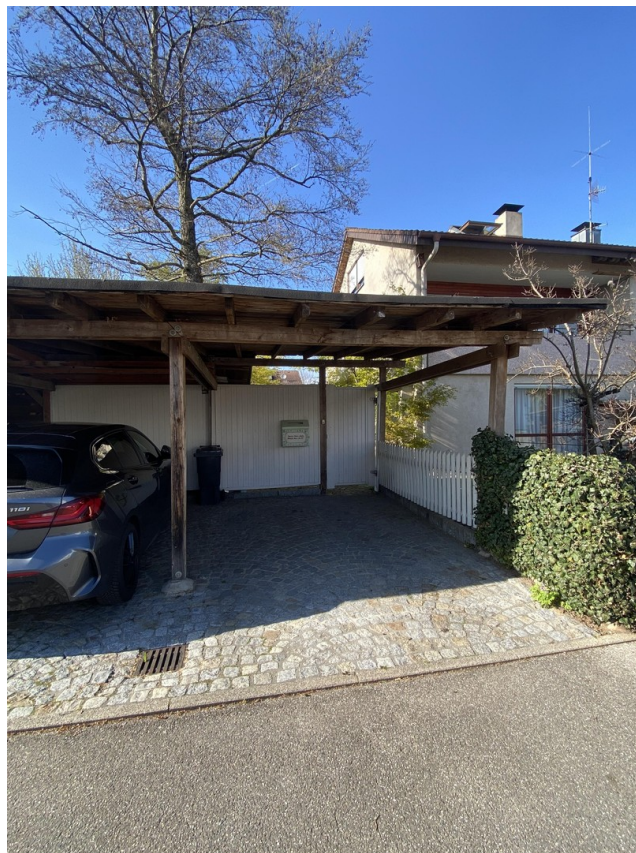
Doppelcarport mit Eingang
