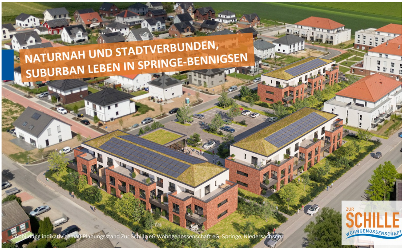
Zur Schille eG – Neubau Häuser
