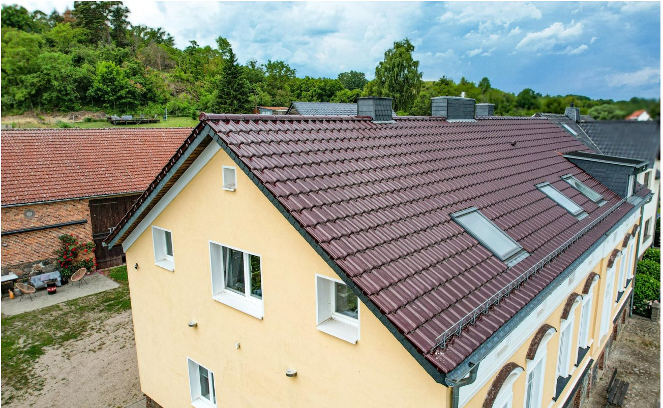
Giebel und Dach Hauptgebäude
