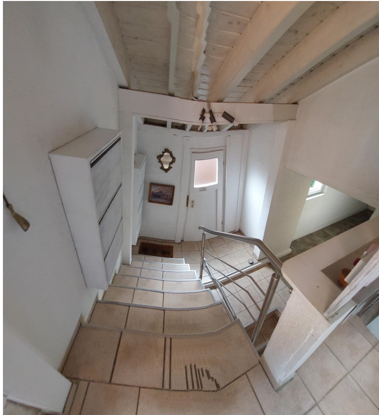
Zugang Treppenhaus Hintereinga
