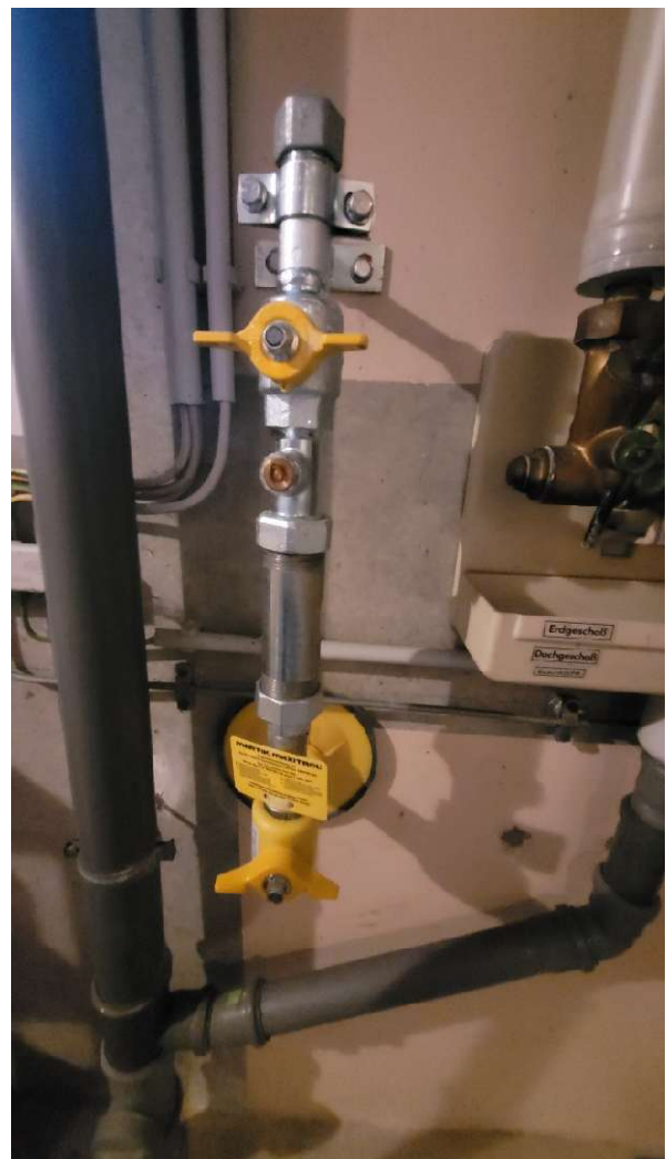
Gasanschluss vorbereitet
