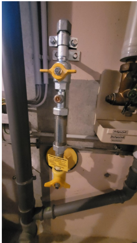
Erdgasanschluss vorbereitet
