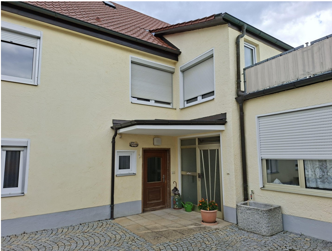
Eingang Wohnung 1 und 2
