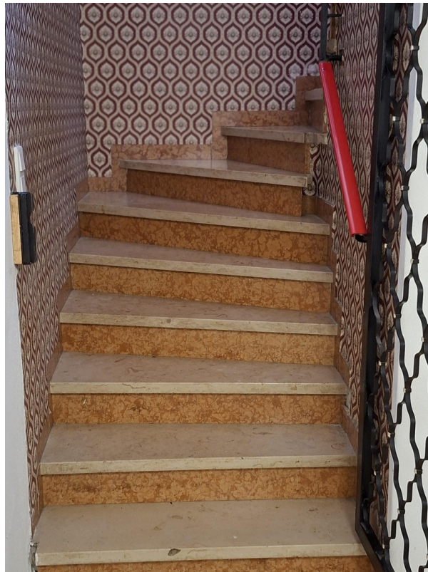
Treppenaufgang zu OG Wohnung 1
