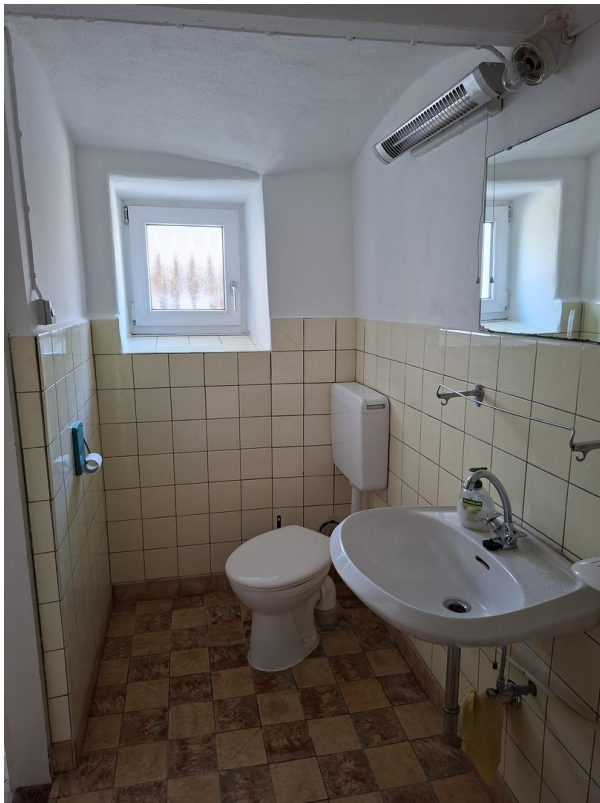
WC/Dusche EG Wohnung 1
