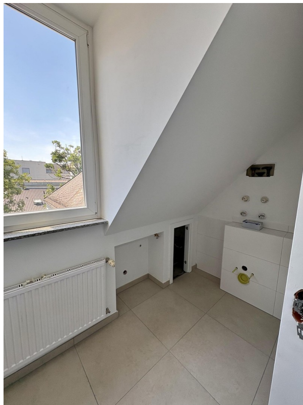
Bad in Fertigstellung
