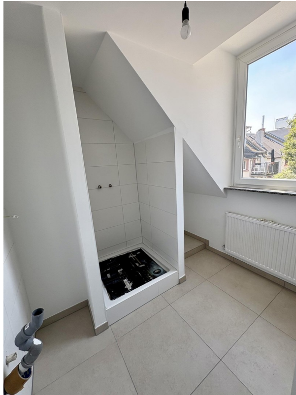
Bad in Fertigstellung
