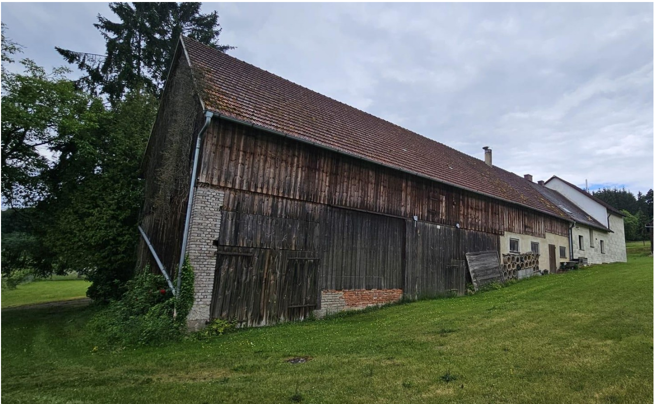
Ansicht Scheune,Stall,WH Nord
