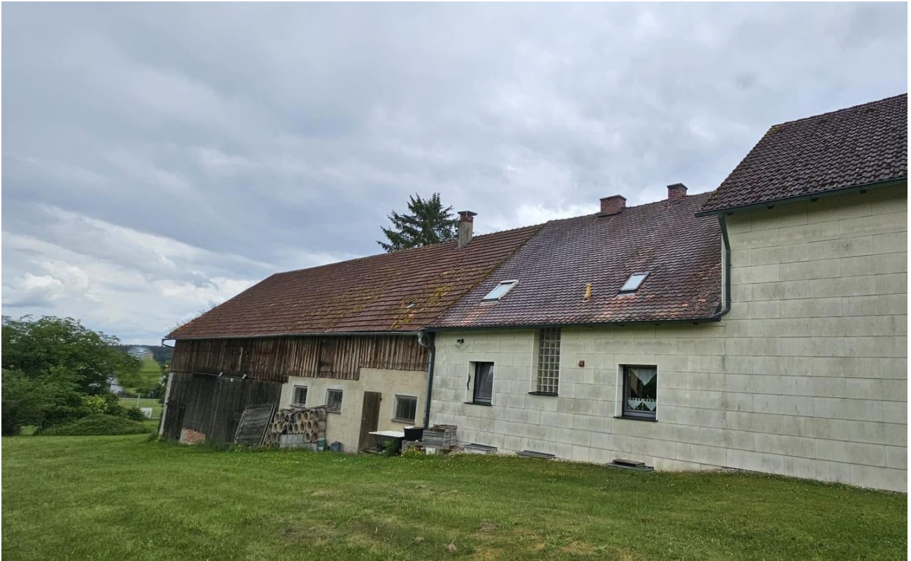
Ansicht WH,Stall,Scheune Nord
