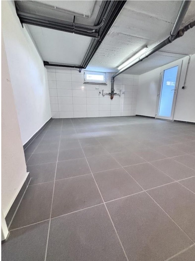
Wasch- und Trockenraum
