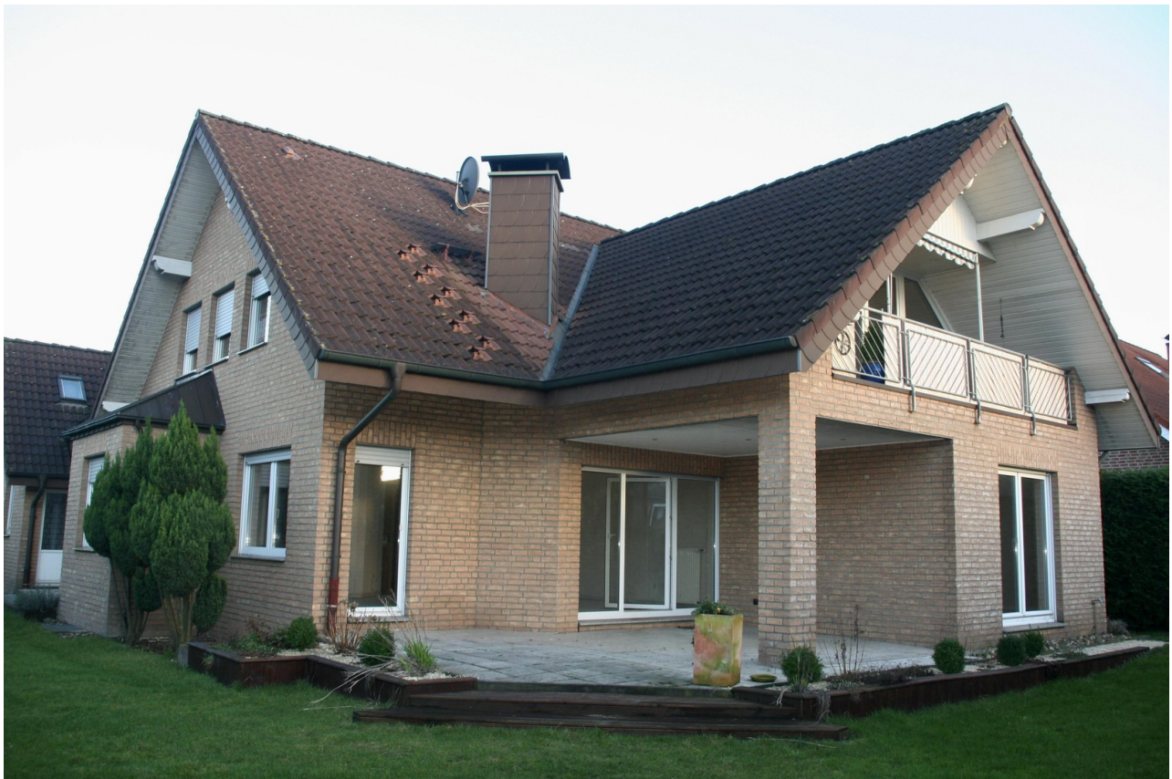
Außen Haus Ansicht Balkon
