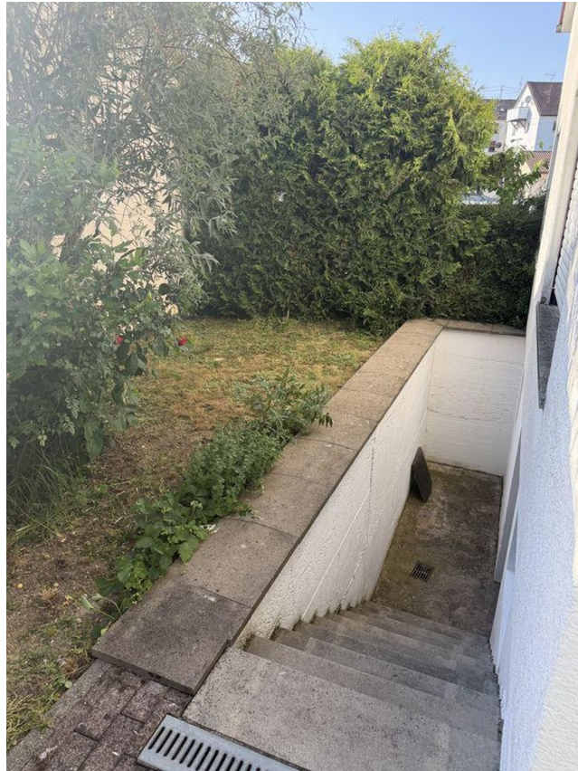
Außenansicht Zugang Keller
