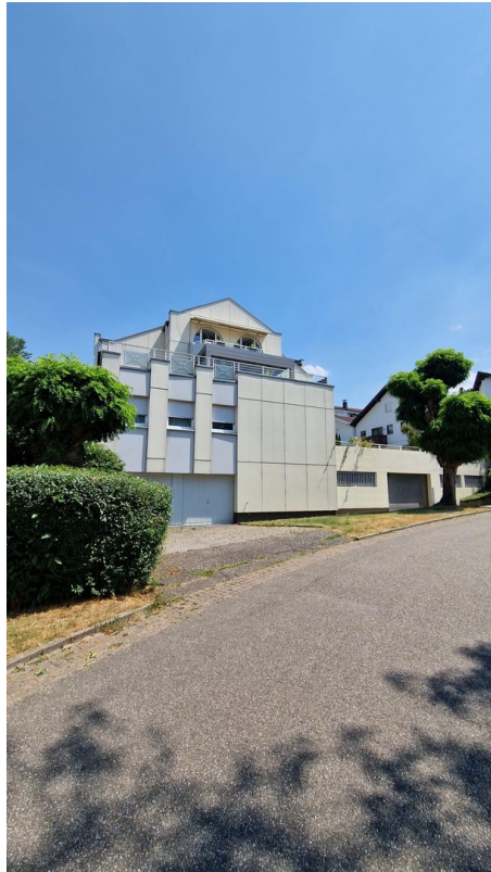
Hausvorderans. u. Garageneinfah
