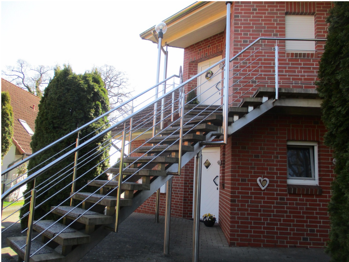
Hauseingang über Treppe
