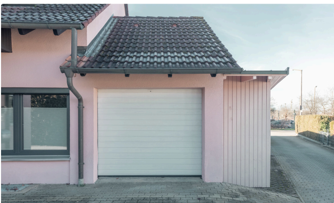
Garage mit elektrischem Tor
