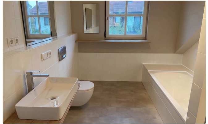
Badezimmer (OG) – neu saniert
