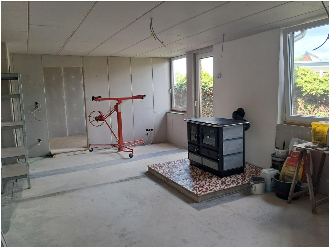
2. Haus Zustand innen mit Hexe
