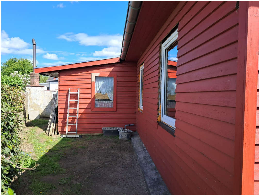
2. Haus außen hinten
