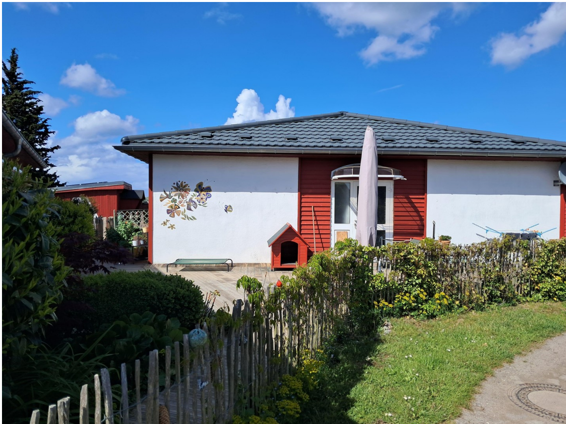
2.Haus(guter Rohbauzustand inn
