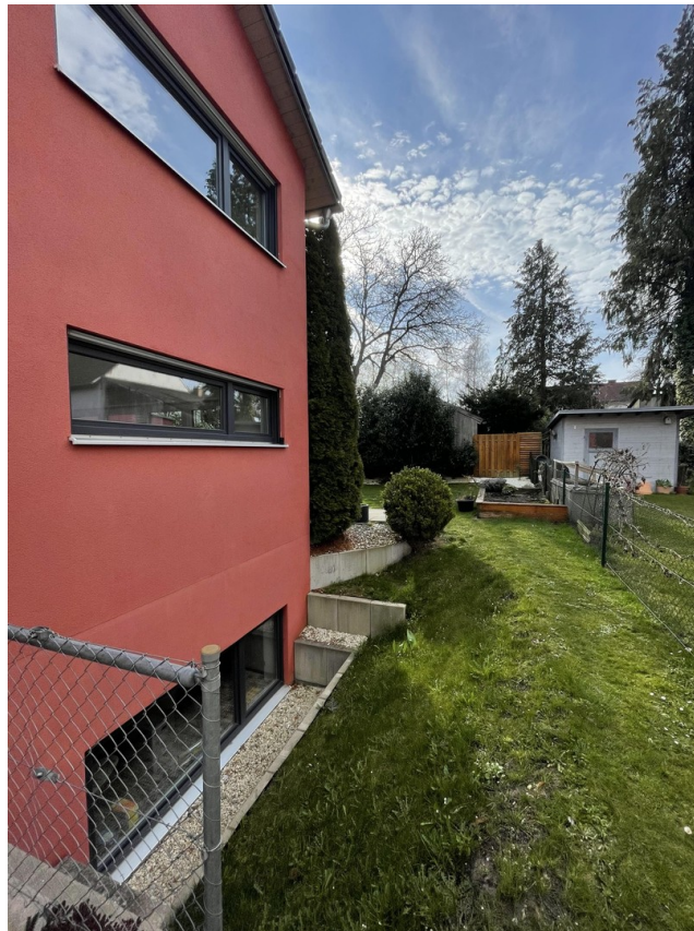
Blick Westseite nach Süden
