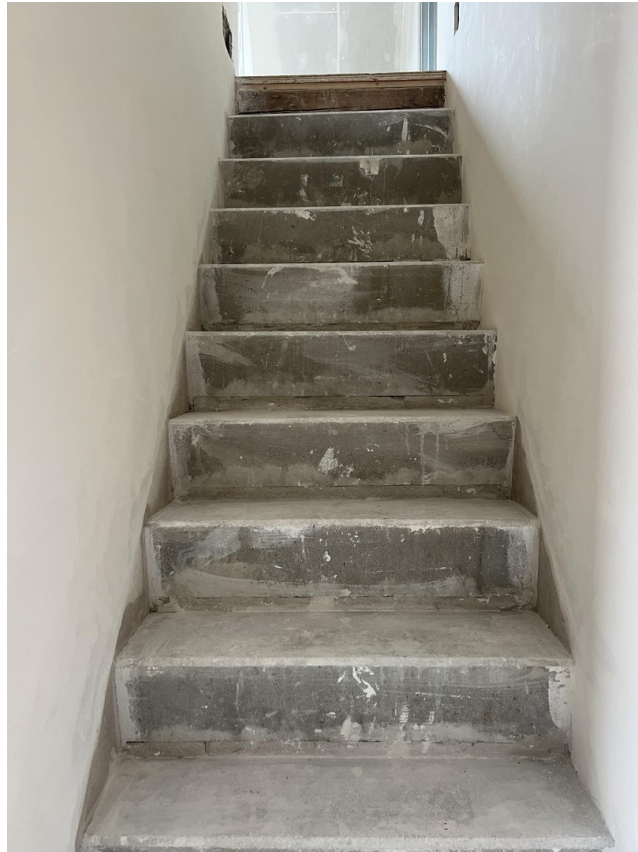
Treppe ins DG
