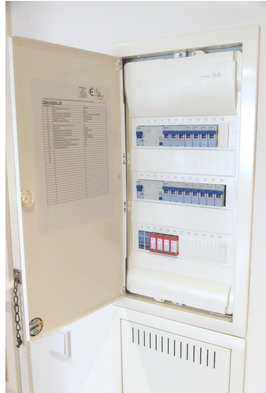
Sicherungskasten
