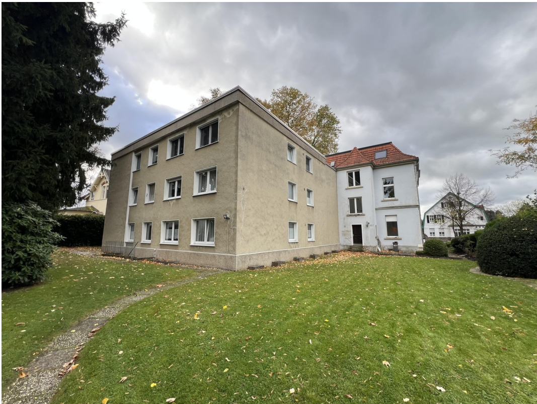
Ansicht rückwärtig mit Eingang
