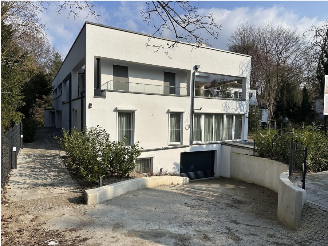
Frontseite Zugang TG
