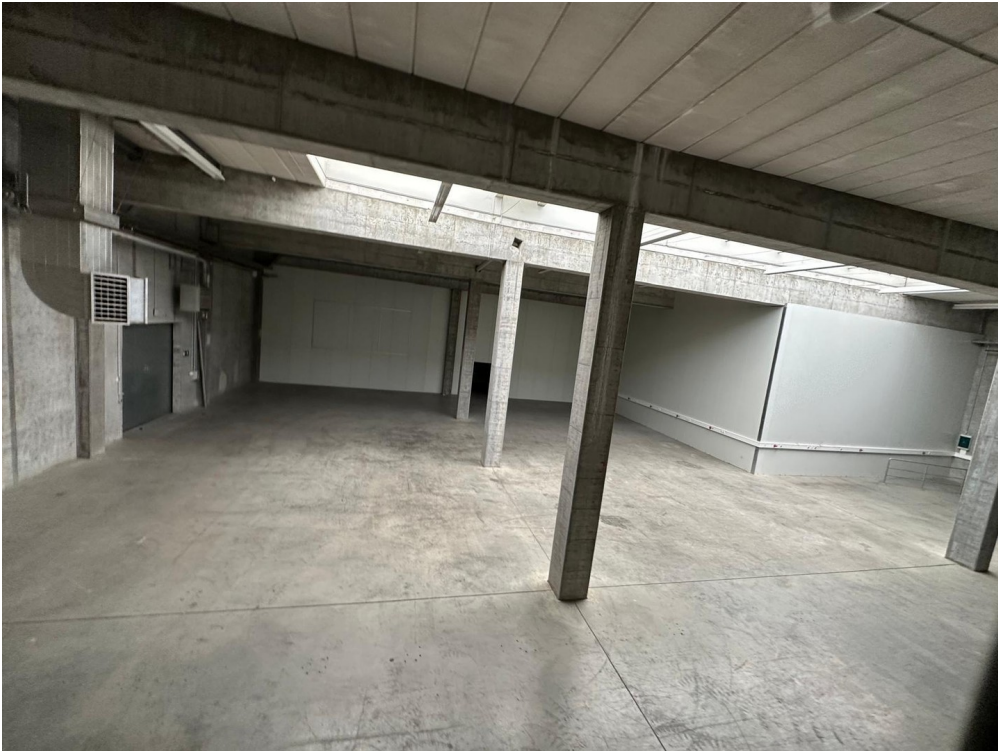
Halle aus Büroblick
