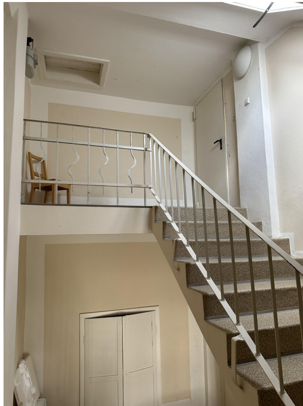
Treppenhaus Zugang Wohnung
