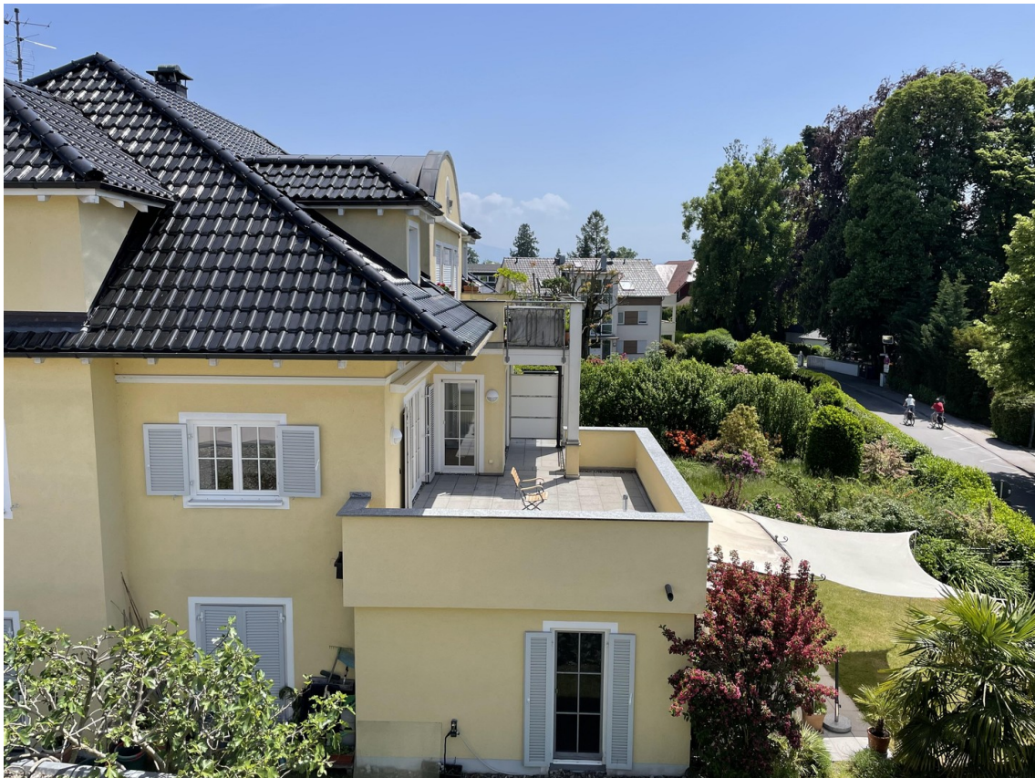
Blick auf die Dachterasse
