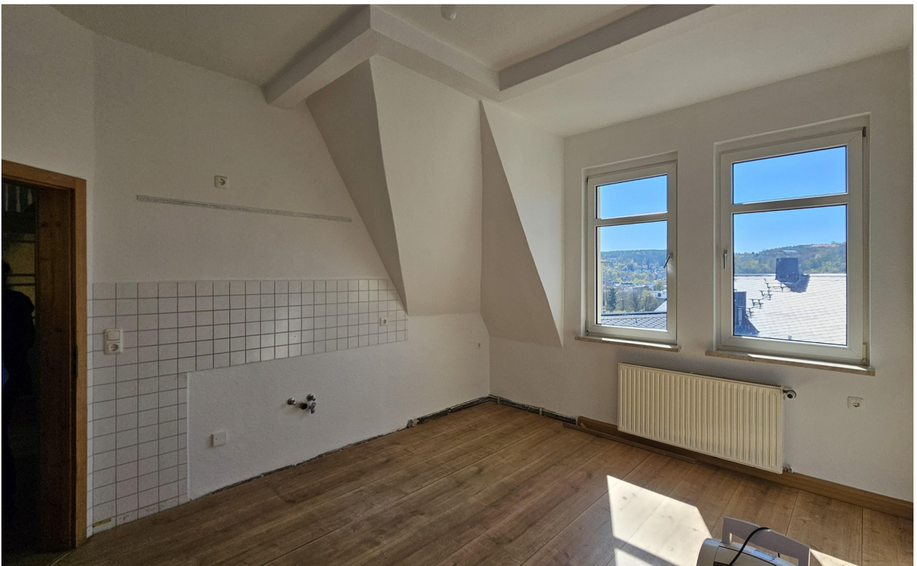
DG - Küche (IST-Zustand)
