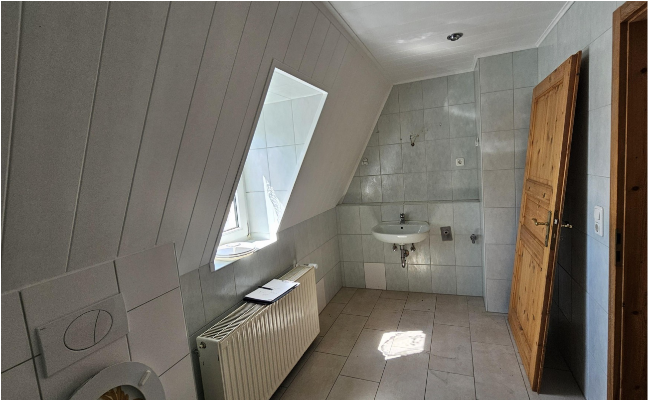
DG- Bad (IST-Zustand)
