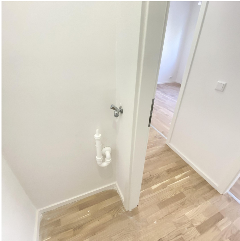
Waschmaschinen Anschluss
