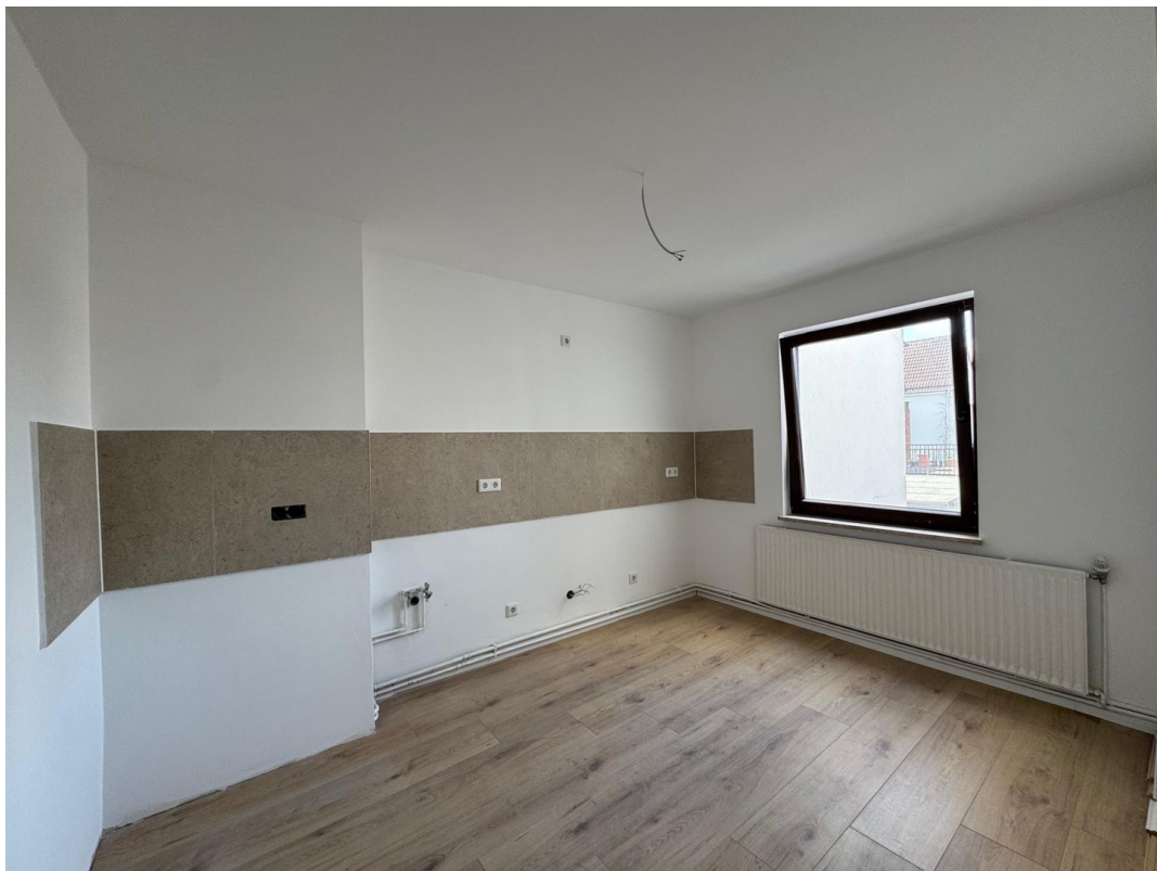
Küche vor Einbau
