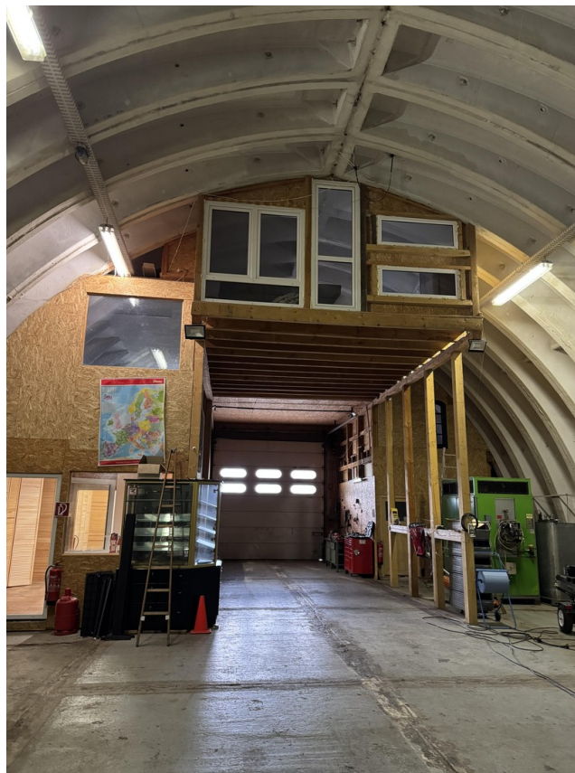
Blick Halle Eingang Lager EG
