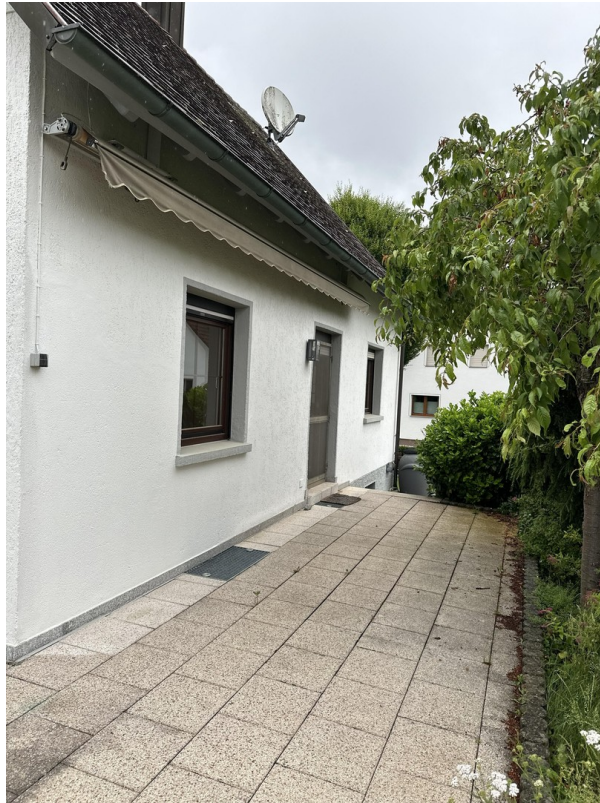
Terrasse elektrische Markise
