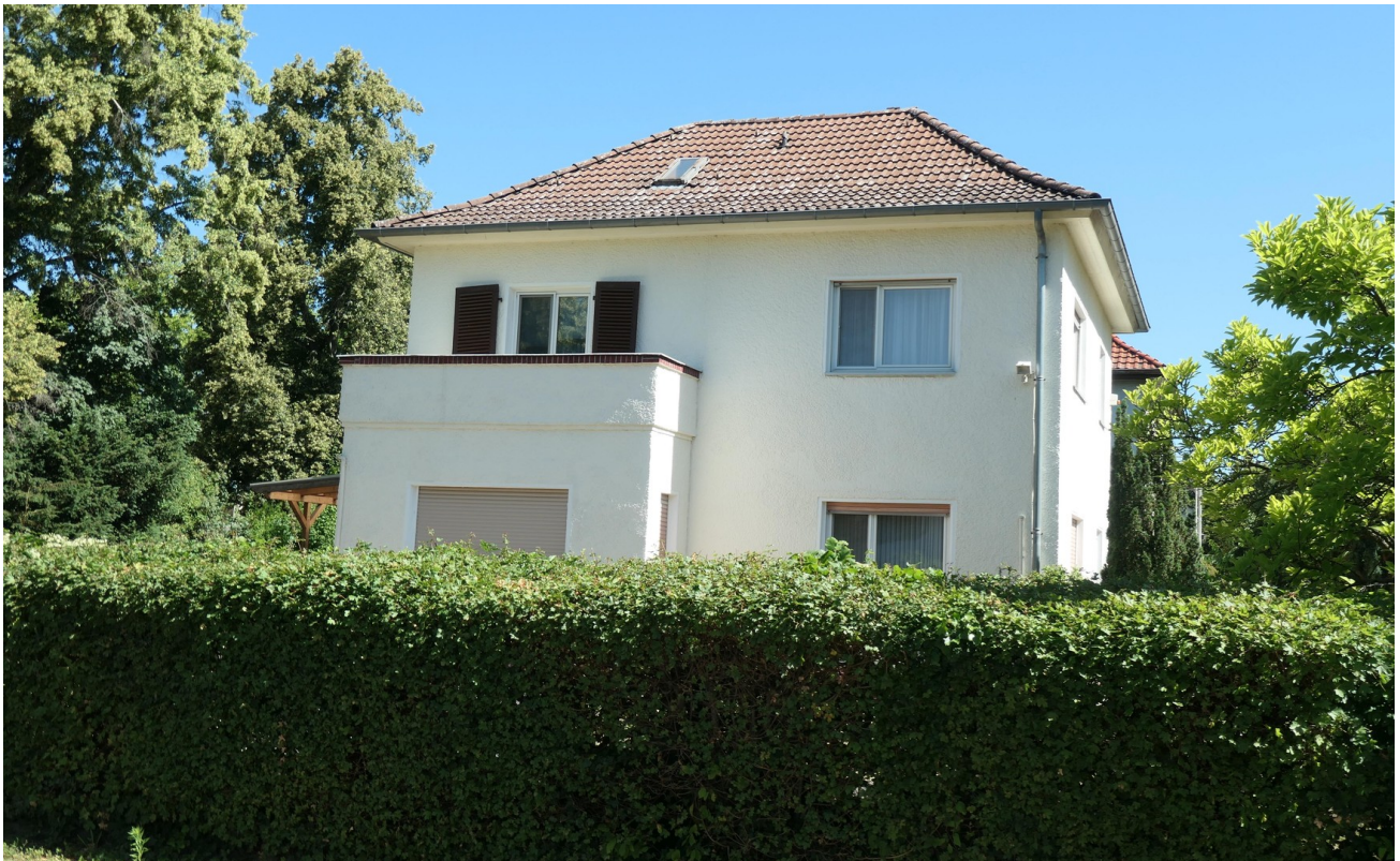
Ansicht Südfassade mit Hecke
