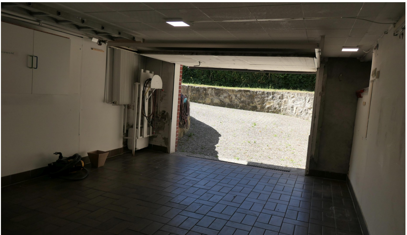
Tiefgarage mit mech.Schwingtür
