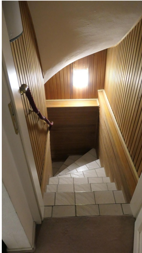
Zugangstreppe zum KG
