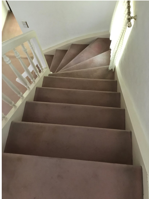
Holztreppe mit Teppichboden
