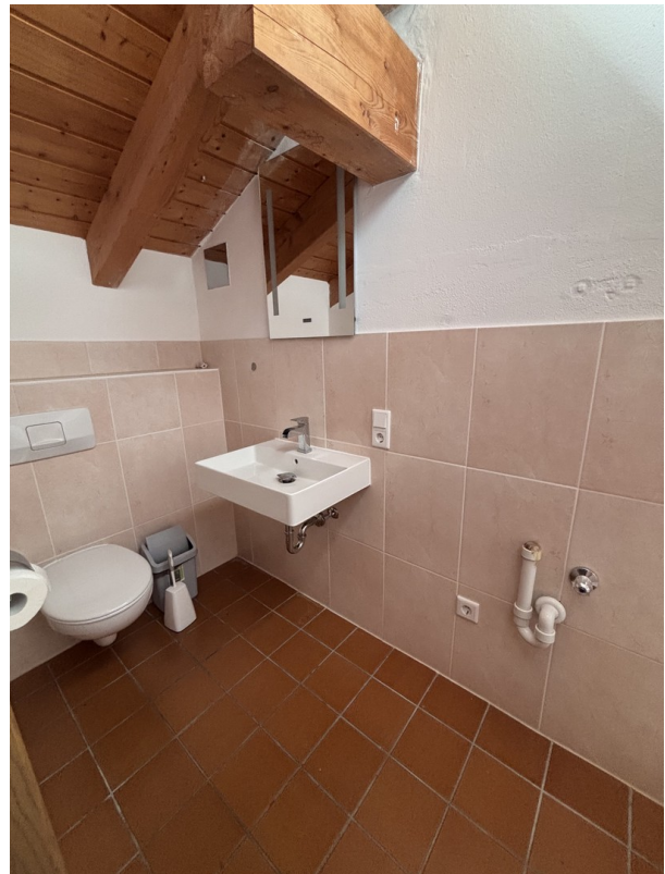
DG 2te Dusche+WC+Waschmasch.
