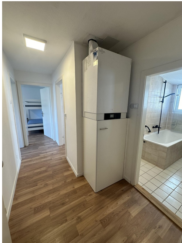
neue Gasetagenheizung
