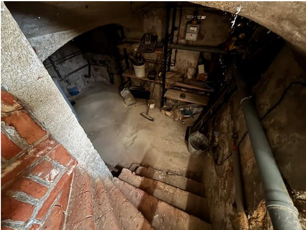
Teilunterkellerung mit Heizung
