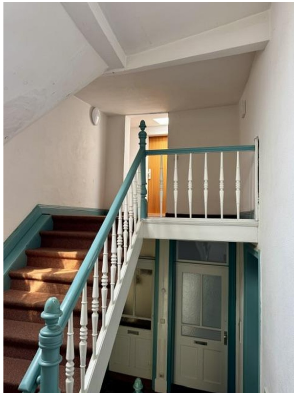
Treppe 4. OG ins DG
