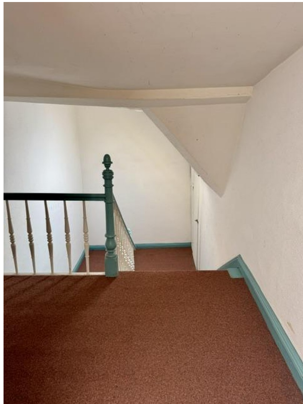
Treppe 4. OG ins DG
