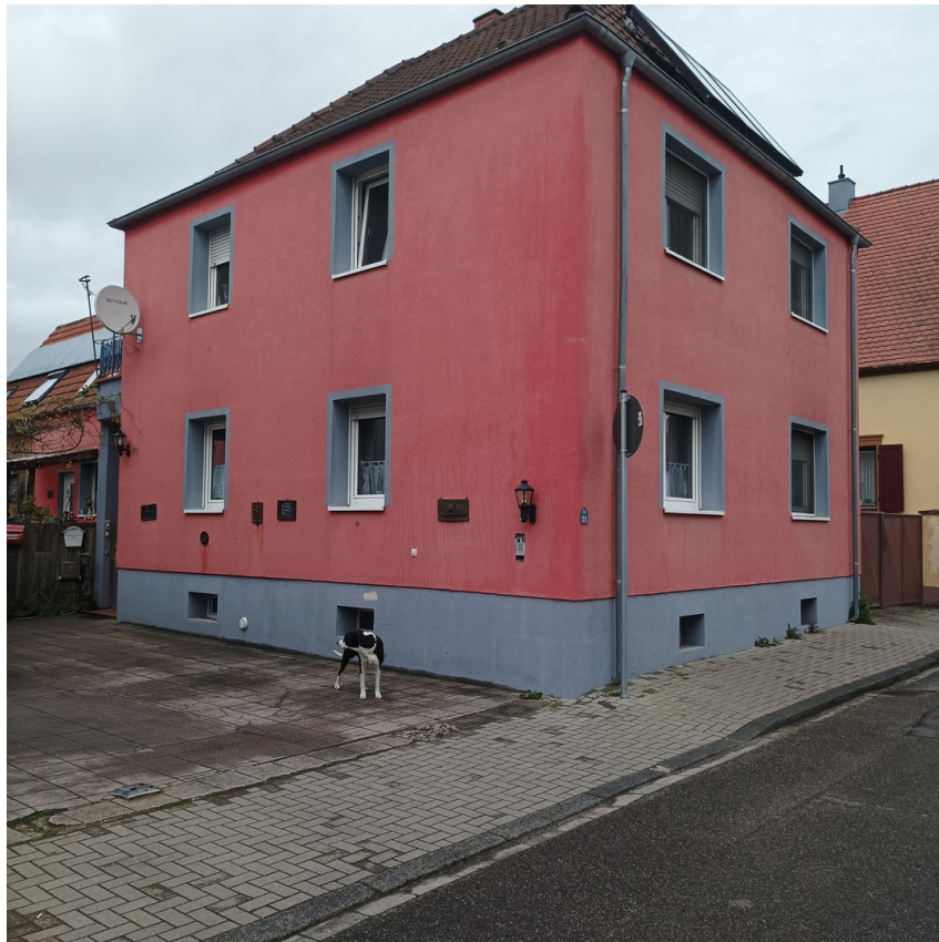
Süd (strasse) West ansicht mit
