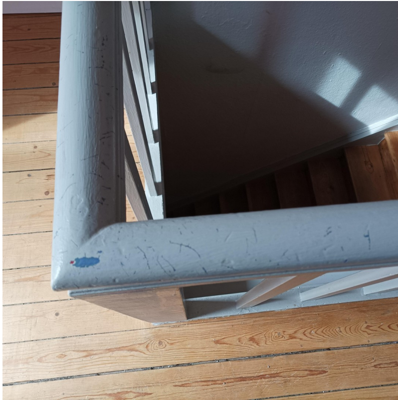
treppengang zum OG Haupth
