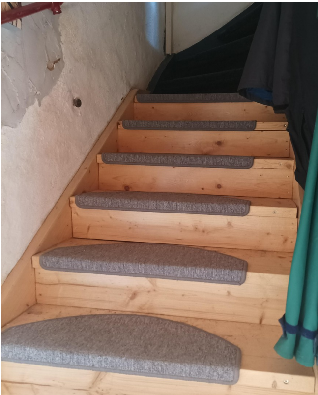
Treppe zum OG hinterhaus
