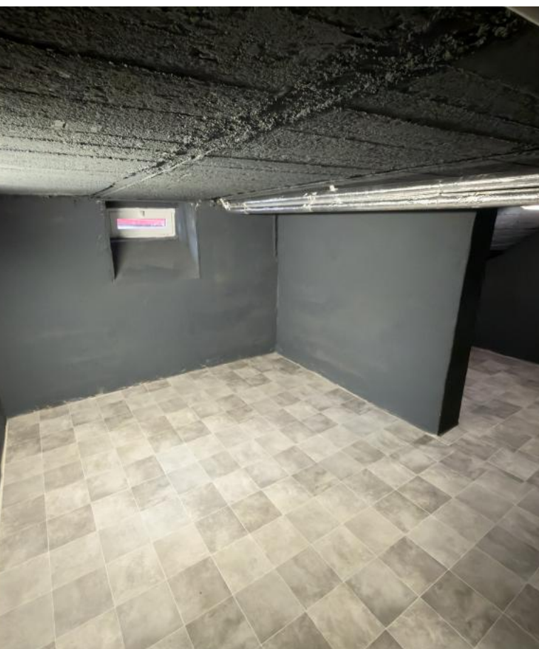
WEITERER BELEUCHTETER KELLER-ABSTELLRAUM
