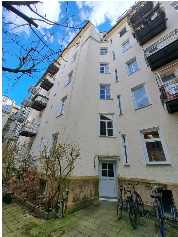
Fassade zum Hof 2
