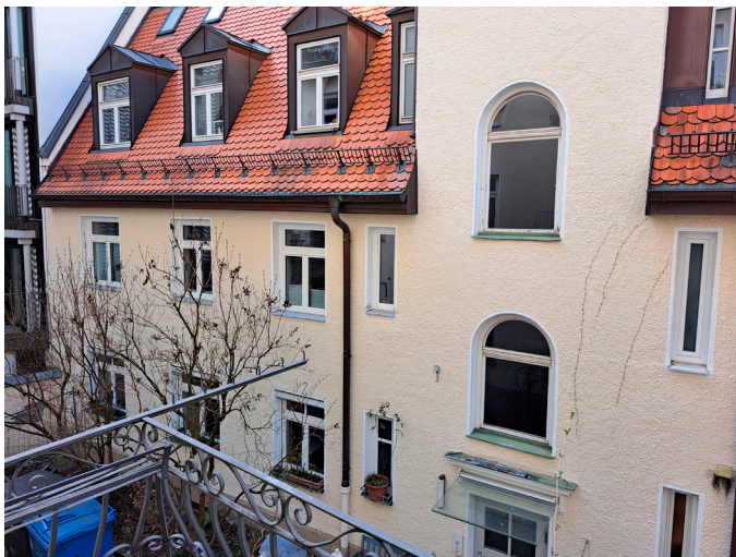
Blick von Balkon zum Rückgebäude
