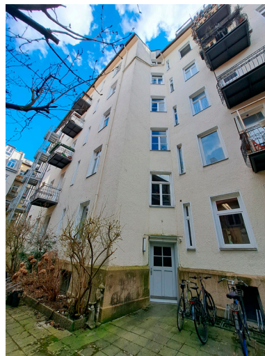
Fassade Erhardtstr. 11 zum Hof 2
