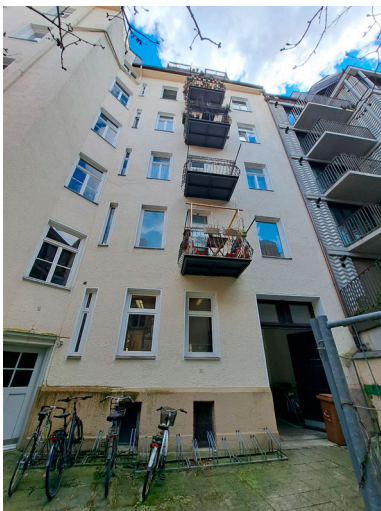
Fassade Erhardtstr. 11 zum Hof 1
